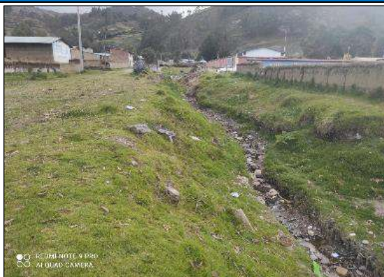
Figura 01. Se muestra la quebrada que atraviesa una zona urbana sin encauzamiento ni obras de protección. El cauce presenta signos de erosión y obstrucción parcial por residuos sólidos y vegetación. Esta situación incrementa la vulnerabilidad del entorno frente a posibles avenidas o lluvias intensas.
