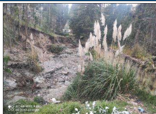
Figura 01. Se muestra la quebrada que atraviesa una zona urbana sin encauzamiento ni obras de protección. El cauce presenta signos de erosión y obstrucción parcial por residuos sólidos y vegetación. Esta situación incrementa la vulnerabilidad del entorno frente a posibles avenidas o lluvias intensas.
